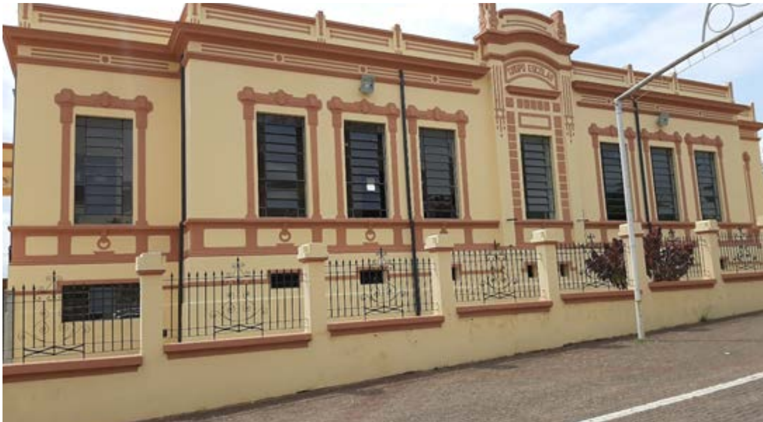
Prédio restaurado da EMEF Paulo Thomaz da Silva - Fachada
