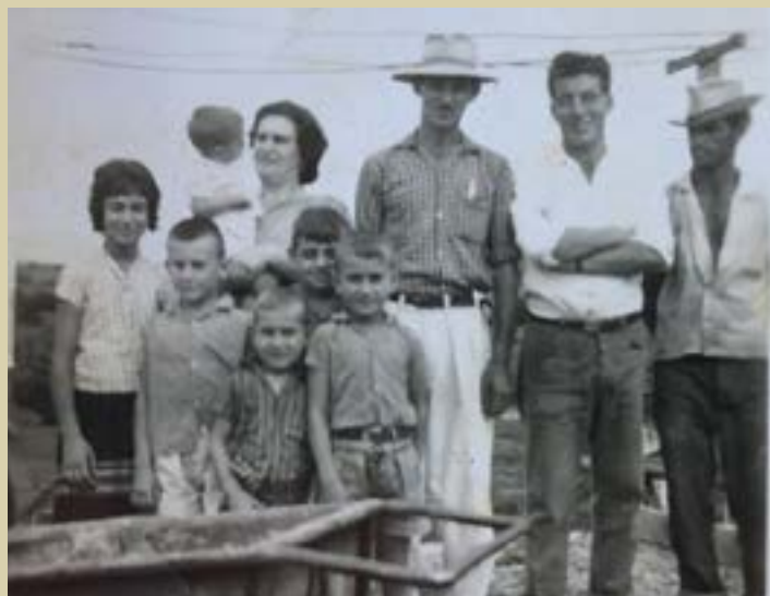
Construção da Ponte Marambaia - foto cedida por Marli Pataro
