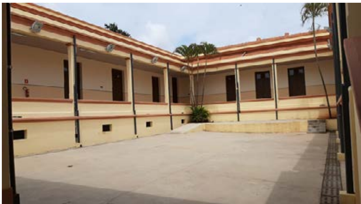
Prédio restaurado da EMEF Paulo Thomaz da Silva - Pátio interno
